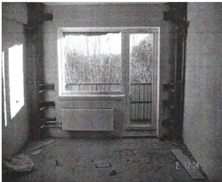
Рисунок.1 Усиление опорного узла.
