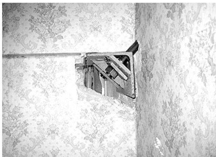
Рисунок.2 Усиление опорного узла анкерным устройством.
