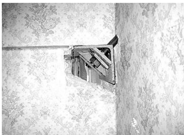
Рисунок.2 Усиление опорного узла анкерным устройством.
