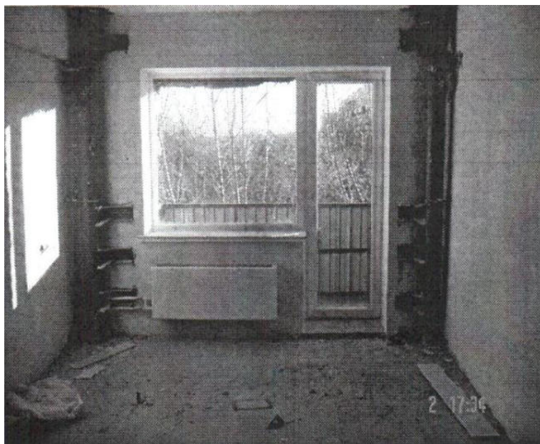
Рисунок.1 Усиление опорного узла.
